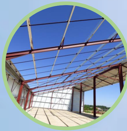
Construction d'un bâtiment neuf
