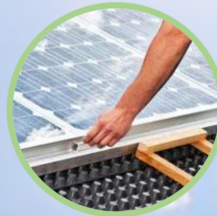
Rénovation d'une toiture existante
