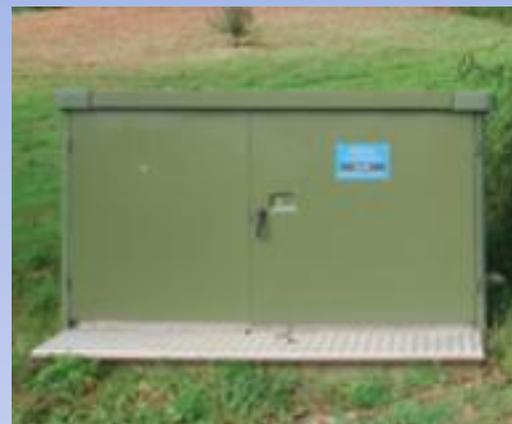
Pour des gammes de puissance plus faibles (100 à 250 kVA) : les PSS. Ils sont de deux types A ou B selon leur emplacement sur le réseau de distribution.
