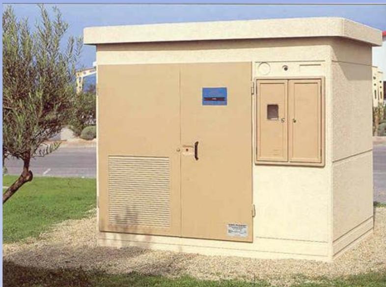
Parmi les postes de la gamme actuelle agréée par le distributeur, ce type de poste est le plus puissant. Il permet d'alimenter les usagers d'une puissance allant de 400 à 630 KVA.
