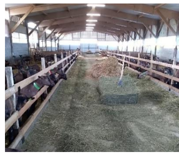
La chèvrerie neuve de 260 places a été construite en 2020
