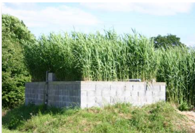
Photo 22 : Le traitement des effluents par les roseaux
