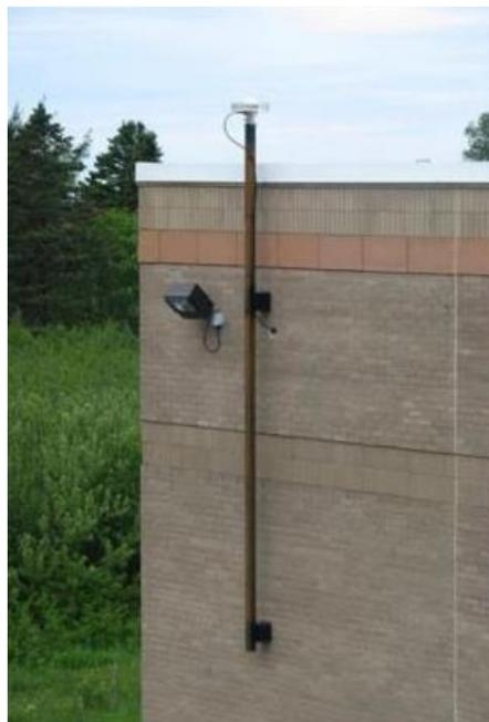
Au moins deux points d'ancrage au mur sur les 2 tiers de la longueur du tube. Eviter les antennes posées sur socle aimanté. Privilégier une fixation boulonnée.
