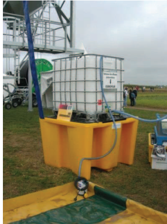
Cuve aérienne posée sur un bac de rétention
