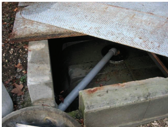
Cuve posée dans une fosse étanche
