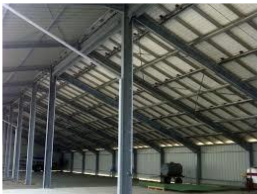
Pose intégrée au bâti
