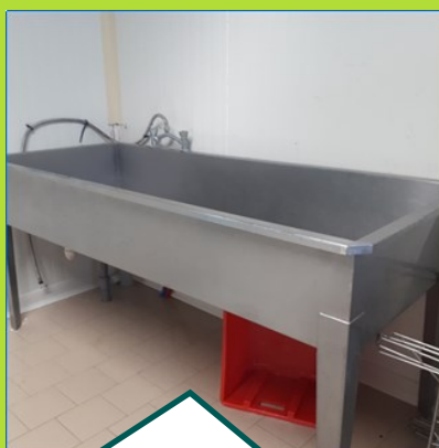
Exemple de bac de trempage ou rinçage - dimensions Hauteur totale 91cm profondeur 30 cm largeur 75 cm longueur 2 m
