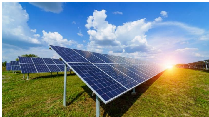
Implantation centrale classique (source photo : Colibri Solar)
