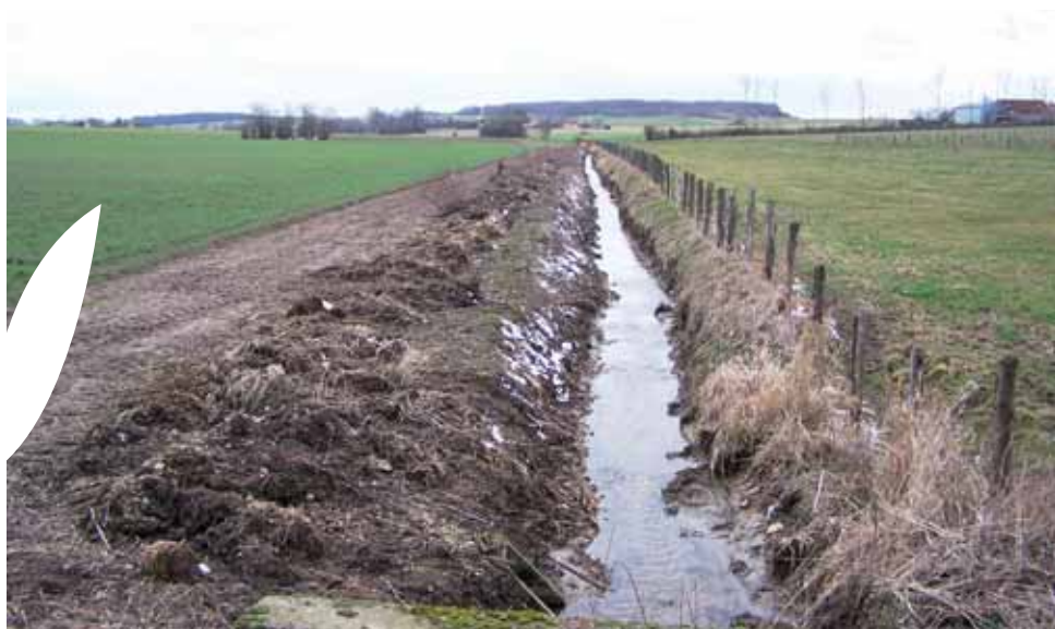
Curage d'un fossé
