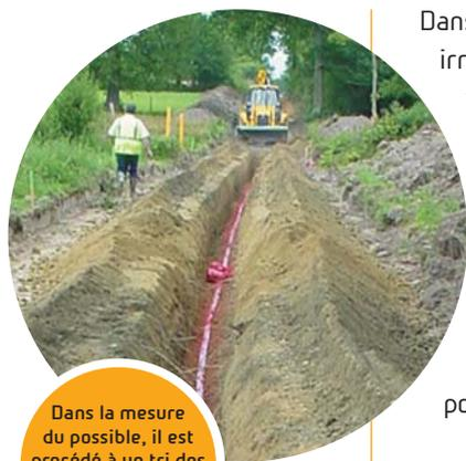
Dans la mesure du possible, il est procédé à un tri des terres à l'ouverture d'une tranchée.
