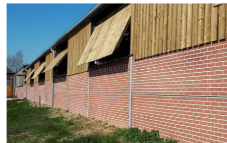
Aménagement d'un volet articulé (CA de l'Aisne)
