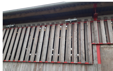
Aménagement d'un bardage ajouré coulissant (IDELE)
